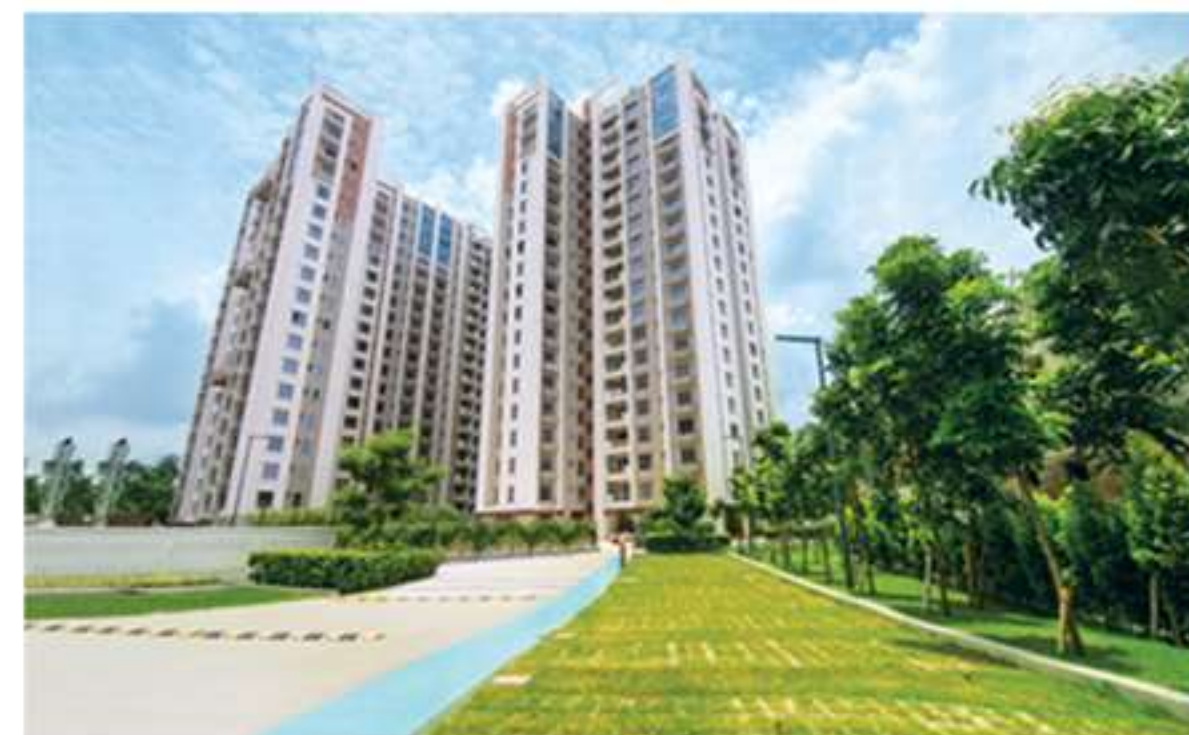
Ozone South EM Bypass
